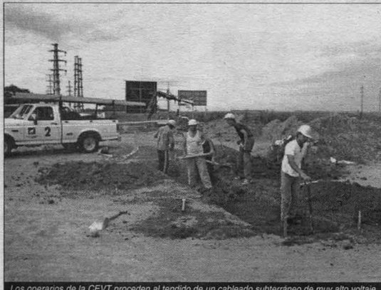
Los operarios de la CEVT proceden al tendido de un cableado subterráneo de muy alto voltaje.
