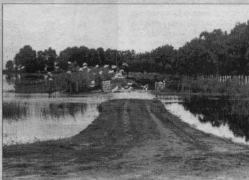
El proyecto prevé obras que impedirán nuevos anegamientos.
