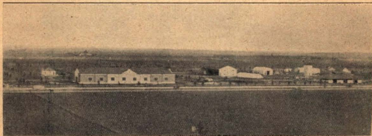
Estado de las obras el día 8 de Setiembre
