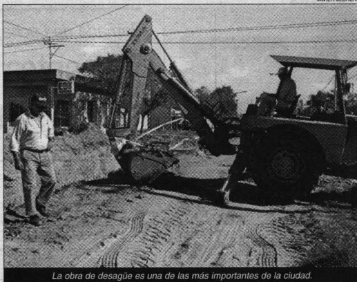
La obra de desagüe es una de las más importantes de la ciudad.
