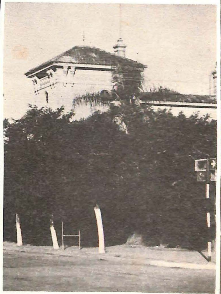
Pertenece a una propiedad ubicada en Mitre entre Casey y Moreno, es uno de los clásicos edificios de nuestra ciudad.
