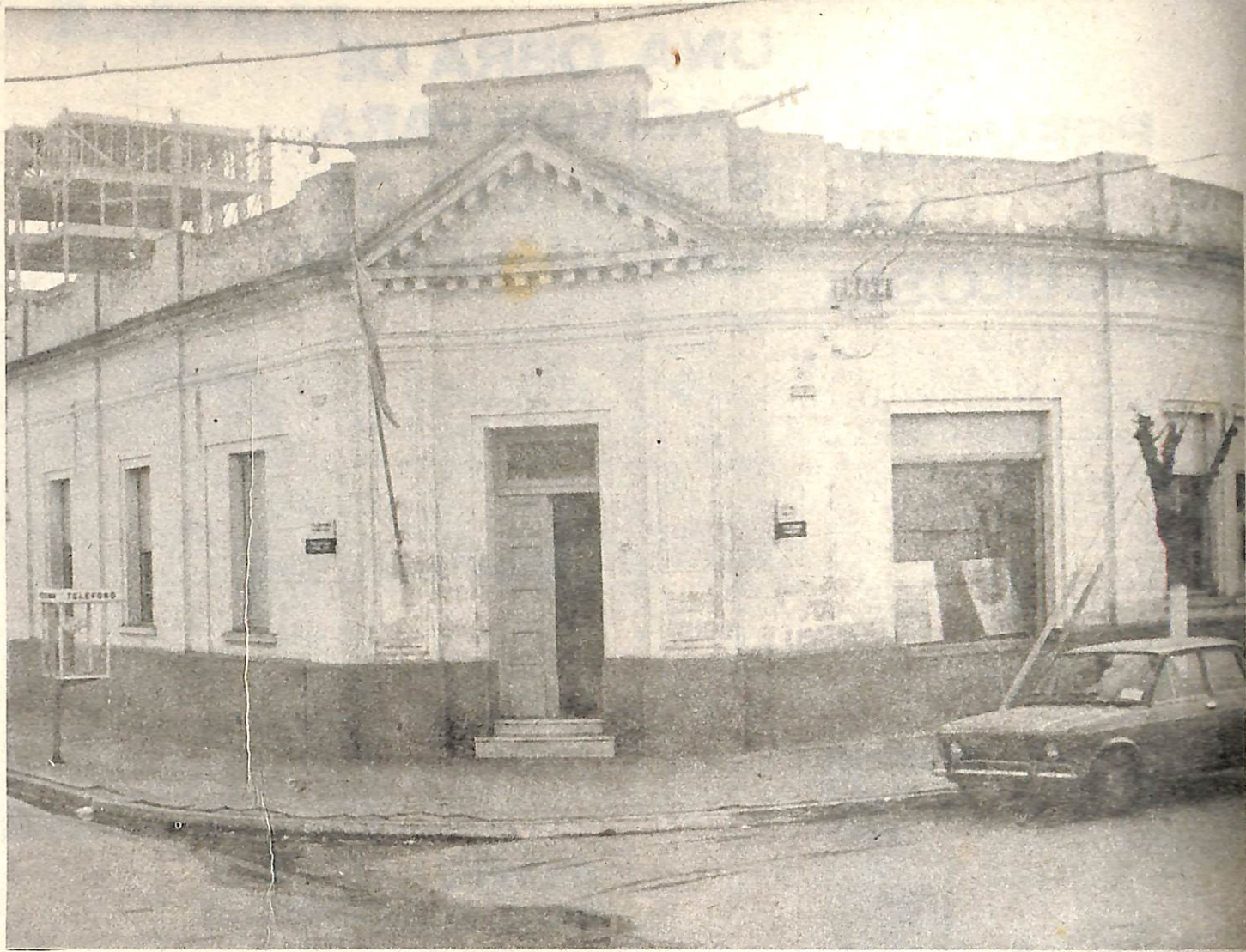
Edificio de ENTEL, antiguo y con comodidades precarias.
