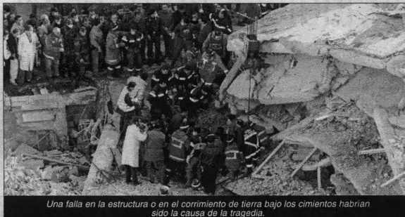
Una falla en la estructura o en el corrimiento de tierra bajo los cimientos habrían sido la causa de la tragedia.
