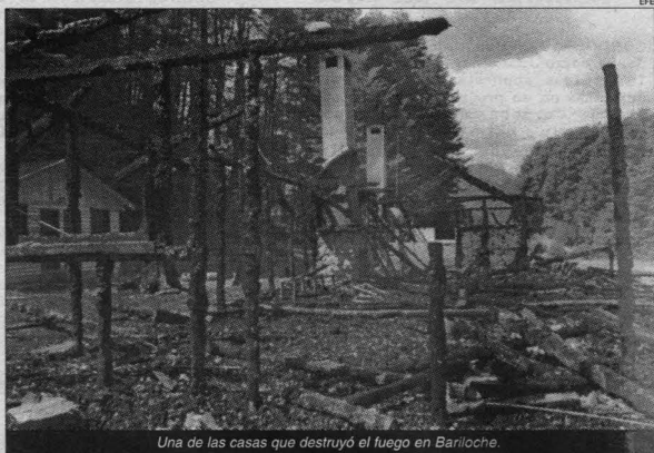
Una de las casas que destruyó el fuego en Bariloche.
