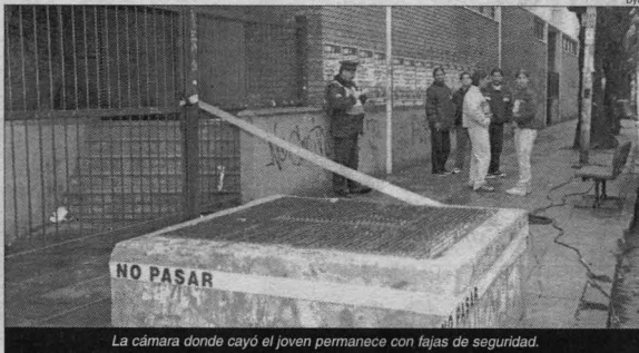
La cámara donde cayó el joven permanece con fajas de seguridad.
