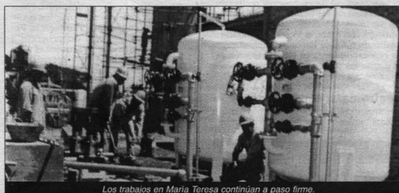
Los trabajos en María Teresa continúan a paso firme.
