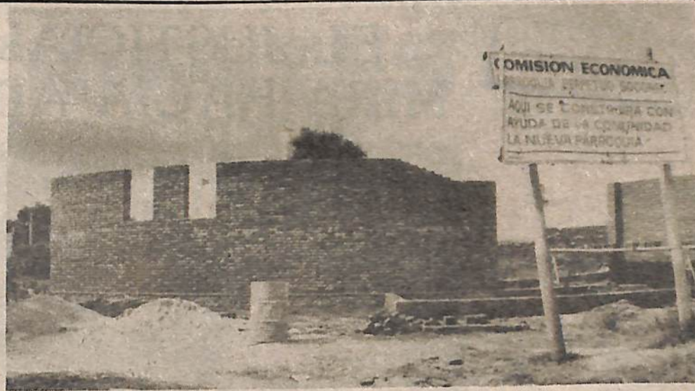
Vista parcial de las obras.
