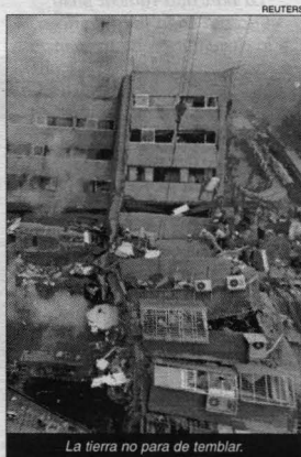
entre los escombros en busca de sobrevivientes.
