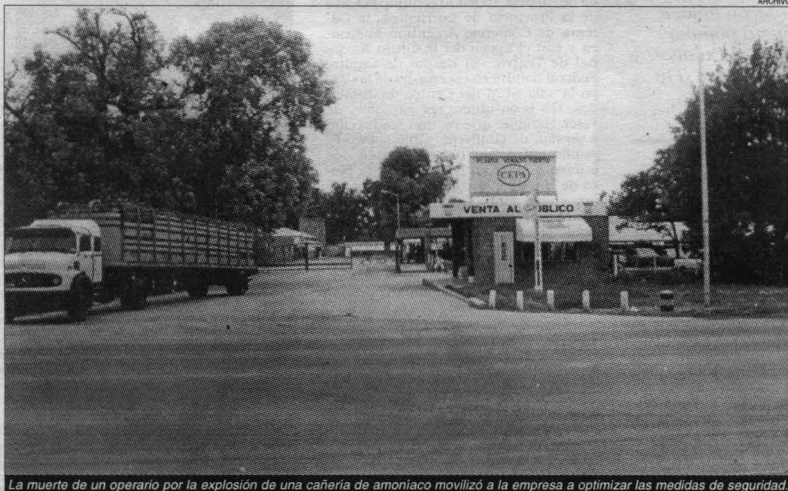
La muerte de un operario por la explosión de una cañería de amoníaco movilizó a la empresa a optimizar las medidas de seguridad.
