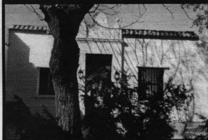
Típica construcción colonial, la casa se desarrolla en una sola planta de paredes de ladrillo asentadas en barro; techo a dos aguas cubierto con tejas rojas acanaladas "musleras"; ventanas con rejas y puertas de tableros salientes.
