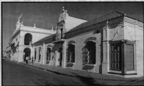
Típica construcción colonial, la casa se desarrolla en una sola planta de paredes de ladrillo asentadas en barro; techo a dos aguas cubierto con tejas rojas acanaladas "musleras"; ventanas con rejas y puertas de tableros salientes.
