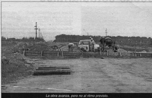
La obra avanza, pero no al ritmo previsto.
