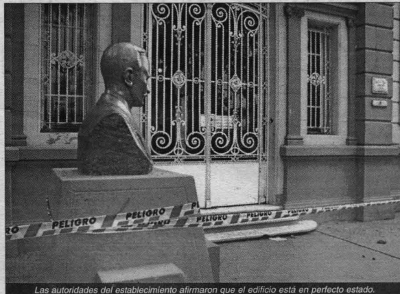
Las autoridades del establecimiento afirmaron que el edificio está en perfecto estado.
