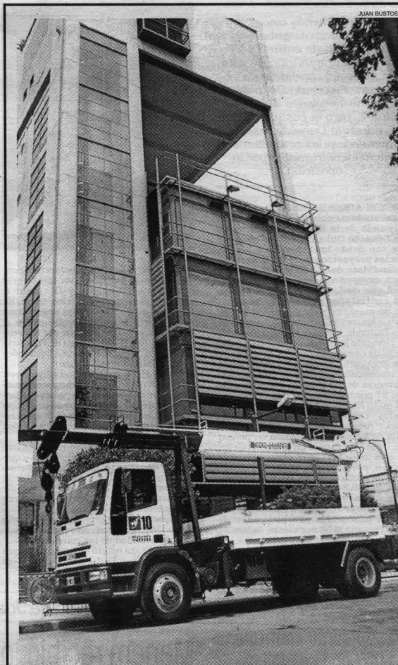
El nuevo camión está equipado con una grúa holandesa. Será de gran utilidad para el mantenimiento de las líneas de media tensión.
