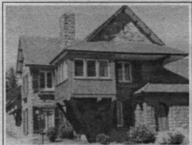
Edificio de Movilidad y Talleres de P.N.
