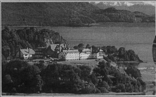
Vista panorámica del hotel reconstruido en mampostería y hormigón.
