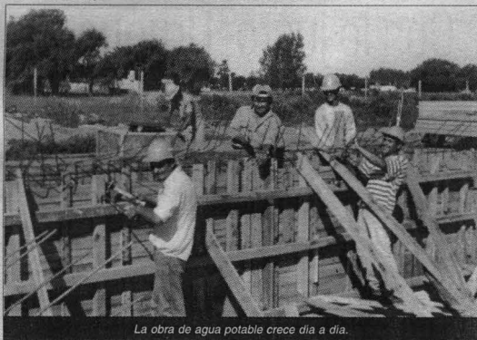
La obra de agua potable crece día a día.
