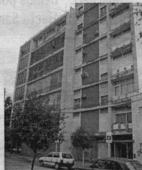
Los edificios públicos y privados deberían tener sistema de iluminación de emergencia.
