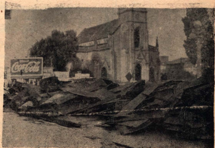
Montón de chapas sacadas por los bomberos en horas de la mañana para poder controlar los últimos focos del incendio.
