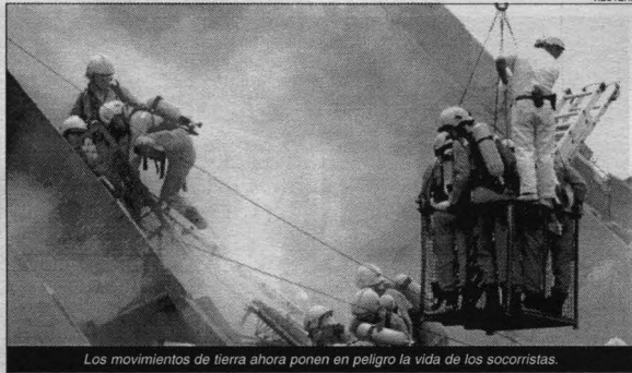
Los movimientos de tierra ahora ponen en peligro la vida de los socorristas.
