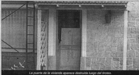
La puerta de la vivienda aparece destruida luego del tiroteo.
