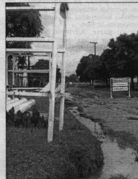
El tendido de la red colectora por las calles del barrio Rivadavia es uno de los principales trabajos de la Cooperativa de Obras Sanitarias.
